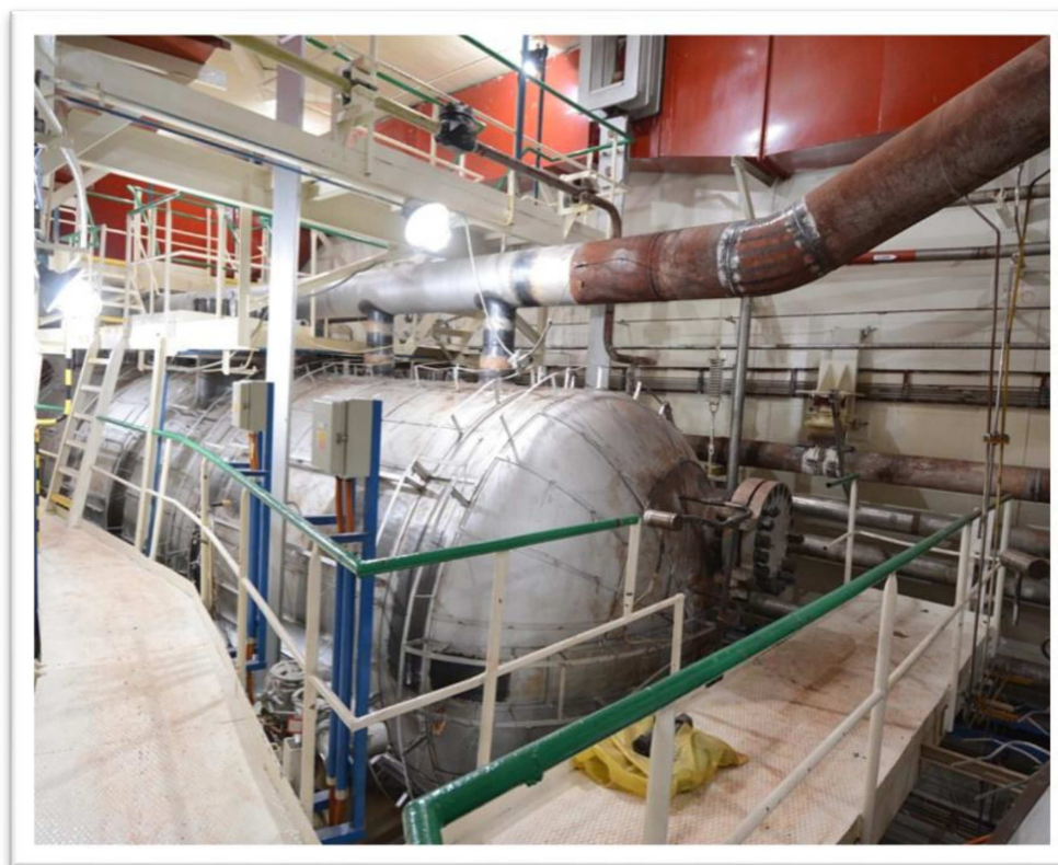
Stav po demontáži izolácií
