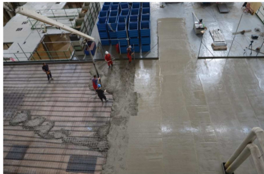
Betonáž rozšíreného kontrolovaného pásma v strojovni
